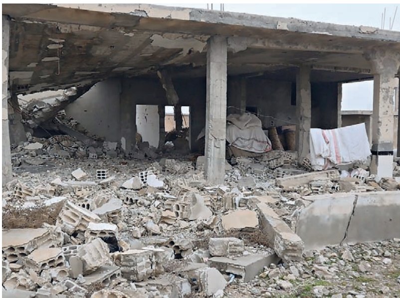
На фото: разрушенный дом Юниса Авада Аль-Хасана, деревня Буайтия, провинция Дейр-эз-Зор.
