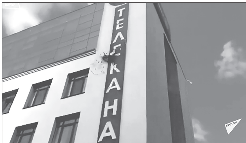
На фото поврежденное 13 июля 2019 года выстрелом из гранатомета здание телеканала «112 Украина»
